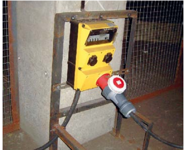
Казанский метрополитен, перегонный тоннель / Россия
